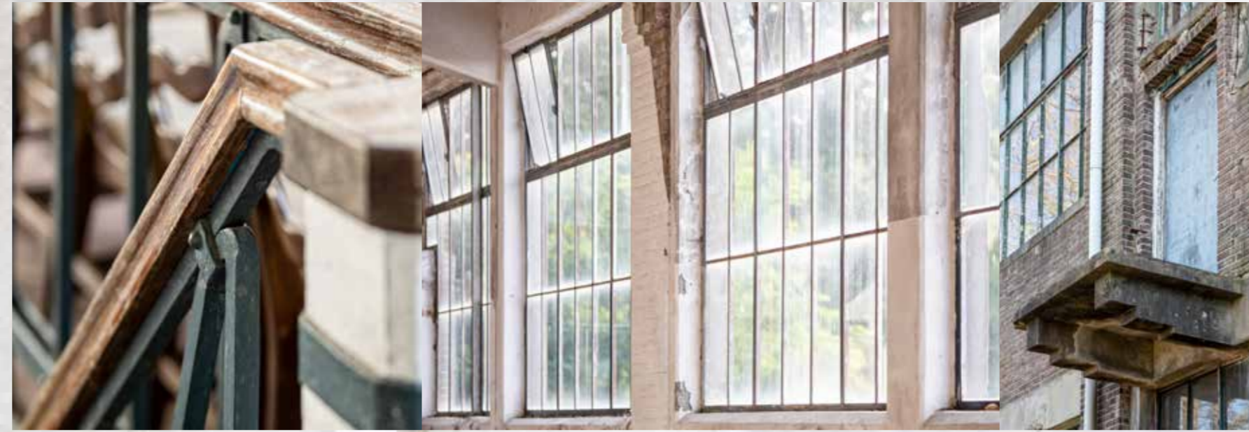
Monumentale trap met smeedijzeren balustrade en houten leuning.
