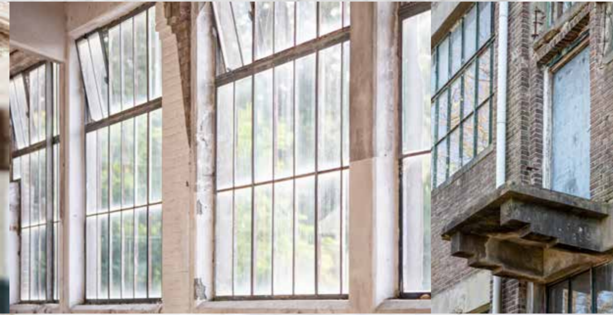
De hoge ramen in stalen kozijnen en met roederverdeling zijn gevat in betonnen omlis-tingen. Vroeger zorgden de riante raampartijen voor meer dan genoeg daglicht in de fabriek, nu verlichten ze je woning.
