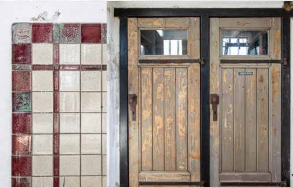
De sanitaire ruimtes bij de zuidgevel, bij bouw-nummers 12 en 18, bevatten nog onderdelen uit de bouwtijd, zoals de art-decotegels en -deuren.
