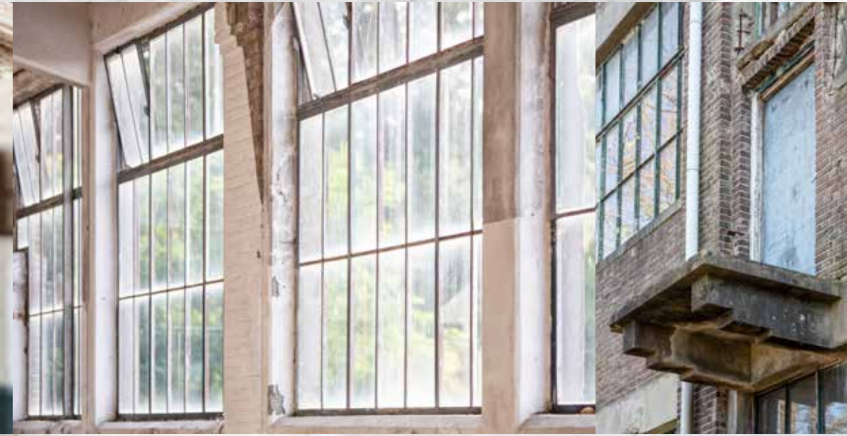
De hoge ramen in stalen kozijnen en met roederverdeling zijn gevat in betonnen omlijstingen. Vroeger zorgden de riante raampartijen voor meer dan genoeg daglicht in de fabriek, nu verlichten ze je woning.
